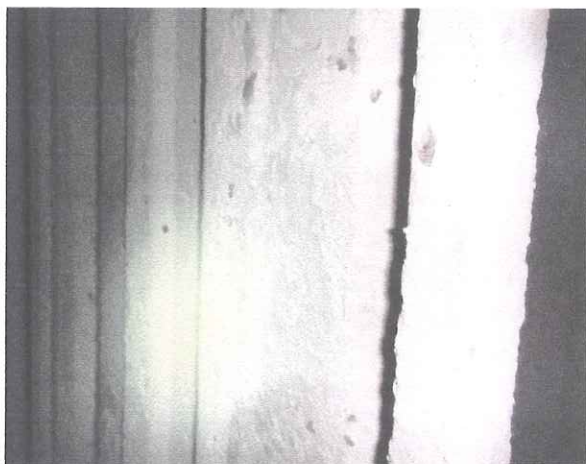
Oklejone nadmiernie pyłem elektrody zbiorcze
