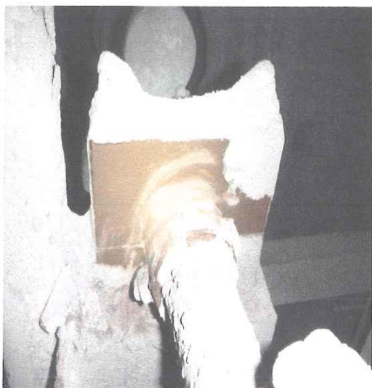
Stan łożysk i nakładek -dobry
