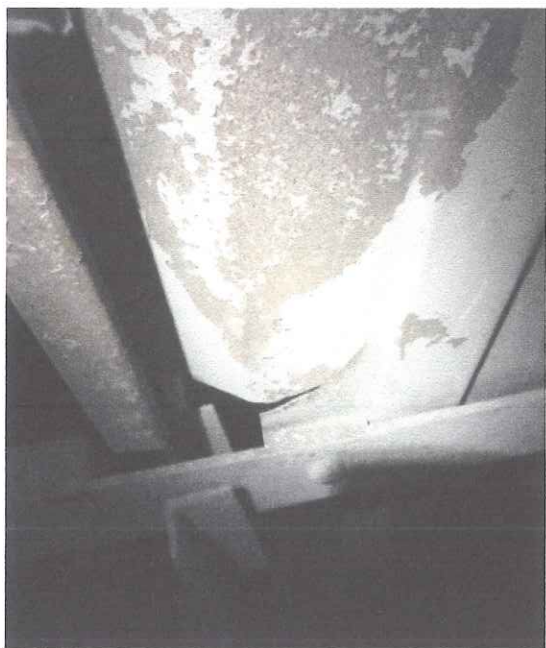
Pęknięcia elektrod w miejscu mocowania z drągiem strzepującym
