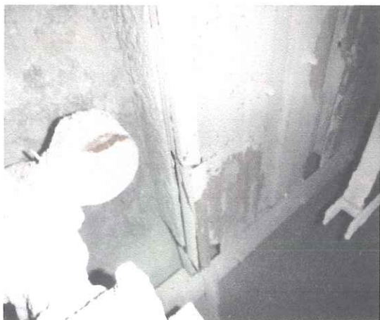
Ślady napraw elektrod w miejscu mocowania z drągiem strzepującym
