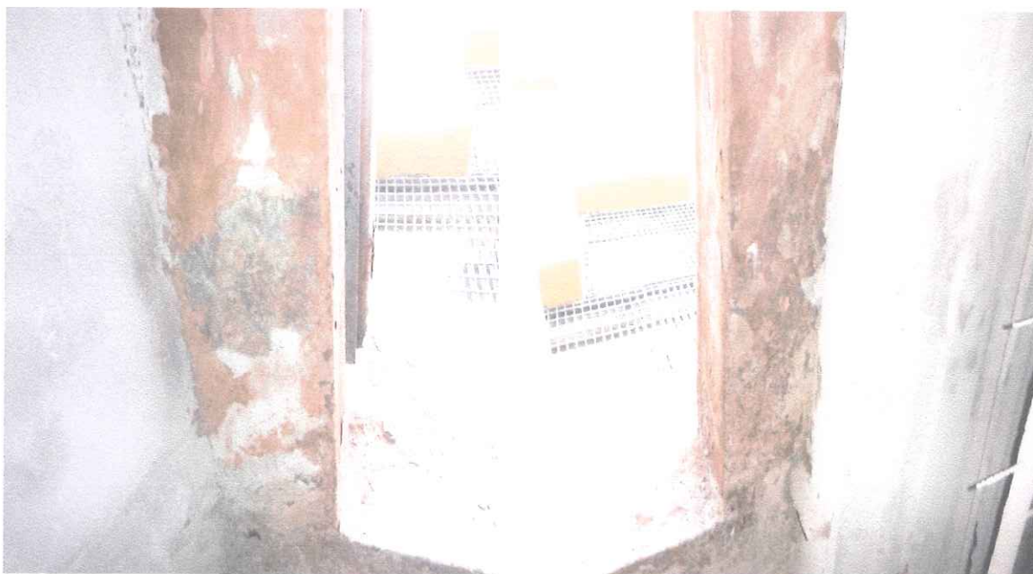
Ślady korozji penetracyjnej na ścianach wokół wjazdów III stref.
